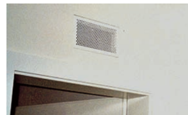
Вариант монтажа ComfoDuct Standard
